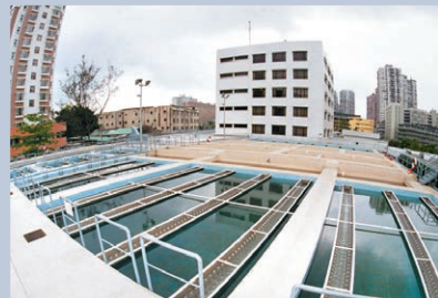
Water Plant 水廠
